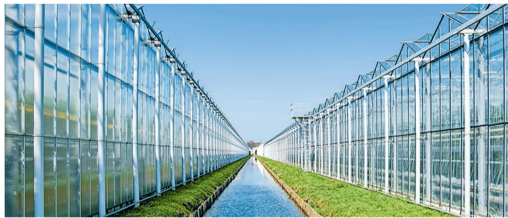
■ Er komen nog te veel voedingsstoffen en gewasbeschermingsmiddelen in het oppervlaktewater terecht. (FOTO: PR)
