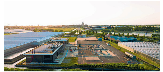
■ Trias Westland is een uniek aardwarmteproject. (FOTO: TRIAS WESTLAND)
