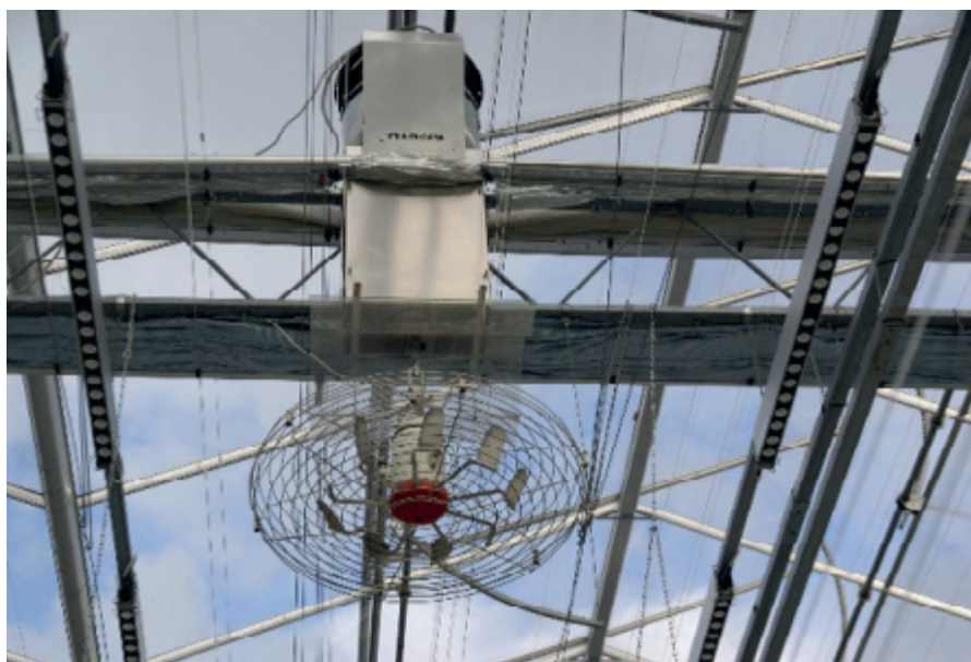
Figuur 1 De VentilationJet die gebruikt werd om de RV te verlagen en meer luchtcirculatie in te kas te verkrijgen.
